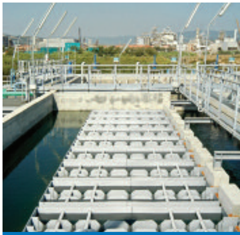
L'impianto Aretusa a Rosignano Solvay
